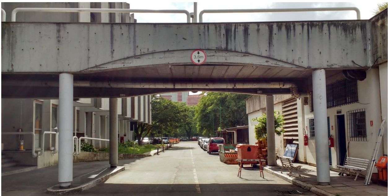
Figura 10-2: vista lateral da passarela de entre prédios principal e de utilidades.
