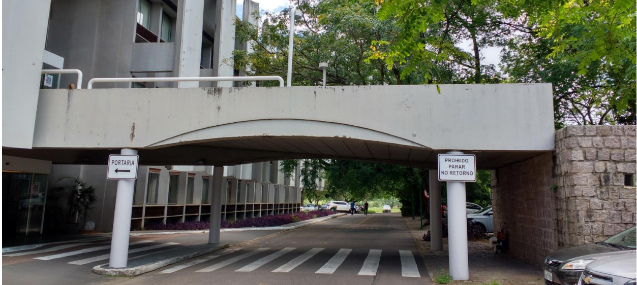
Figura 10-1: vista lateral da passarela de acesso pela Av. Loureiro da Silva.
