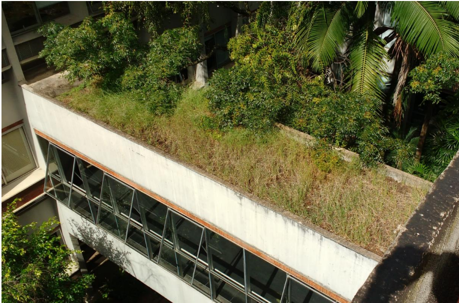
Figura 9-5: cobertura vegetal sobre passarela.
