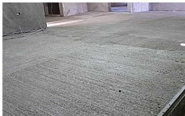
Exemplo de aplicação do piso de concreto vassourado
