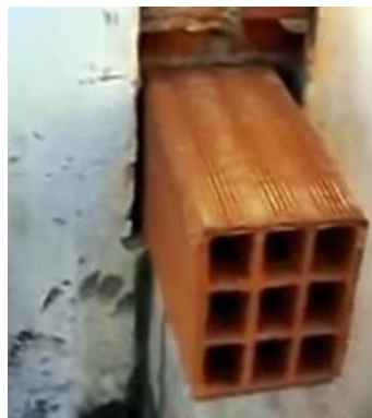
Amarração entre alvenaria nova e existente
