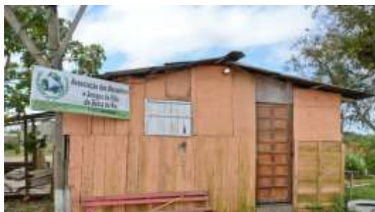
Galpão de reciclagem improvisado construído pela comunidade da Vila Beira do Rio
